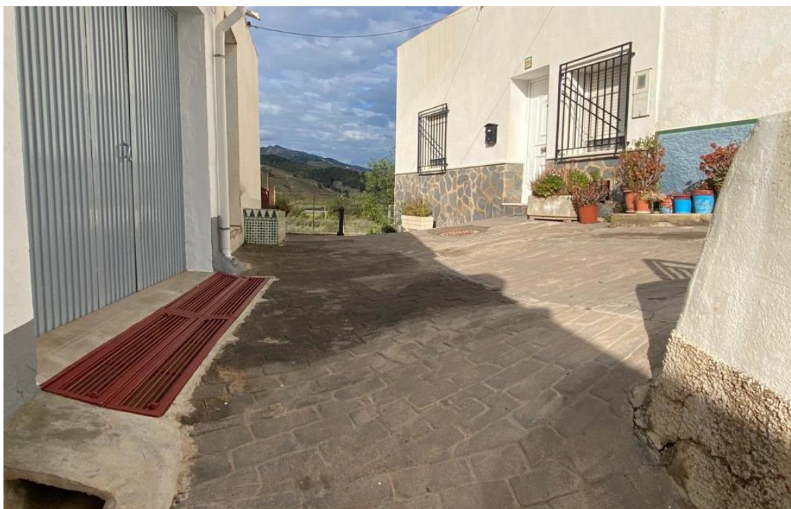
ACTUACIÓN 2. ACONDICIONAMIENTO DE LA CALLE CASTILLO.
