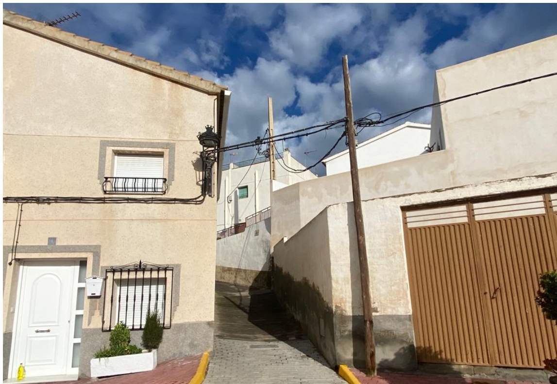
ACTUACIÓN 2. ACONDICIONAMIENTO DE LA CALLE CASTILLO.
