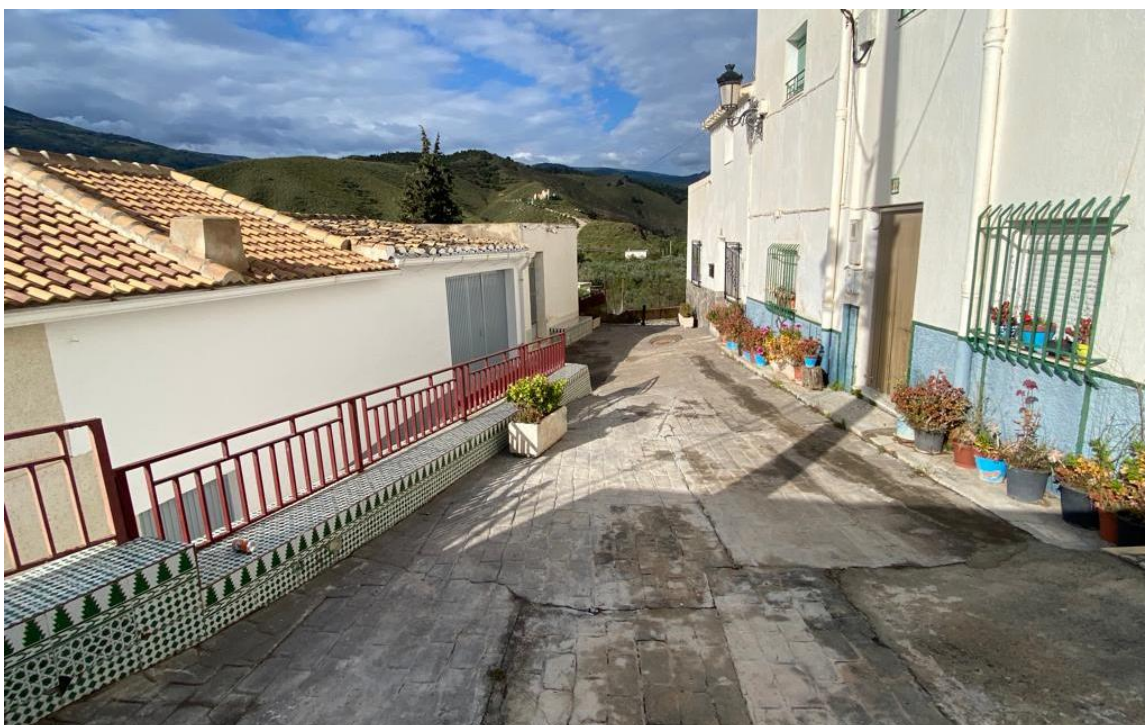
ACTUACIÓN 2. ACONDICIONAMIENTO DE LA CALLE CASTILLO.
