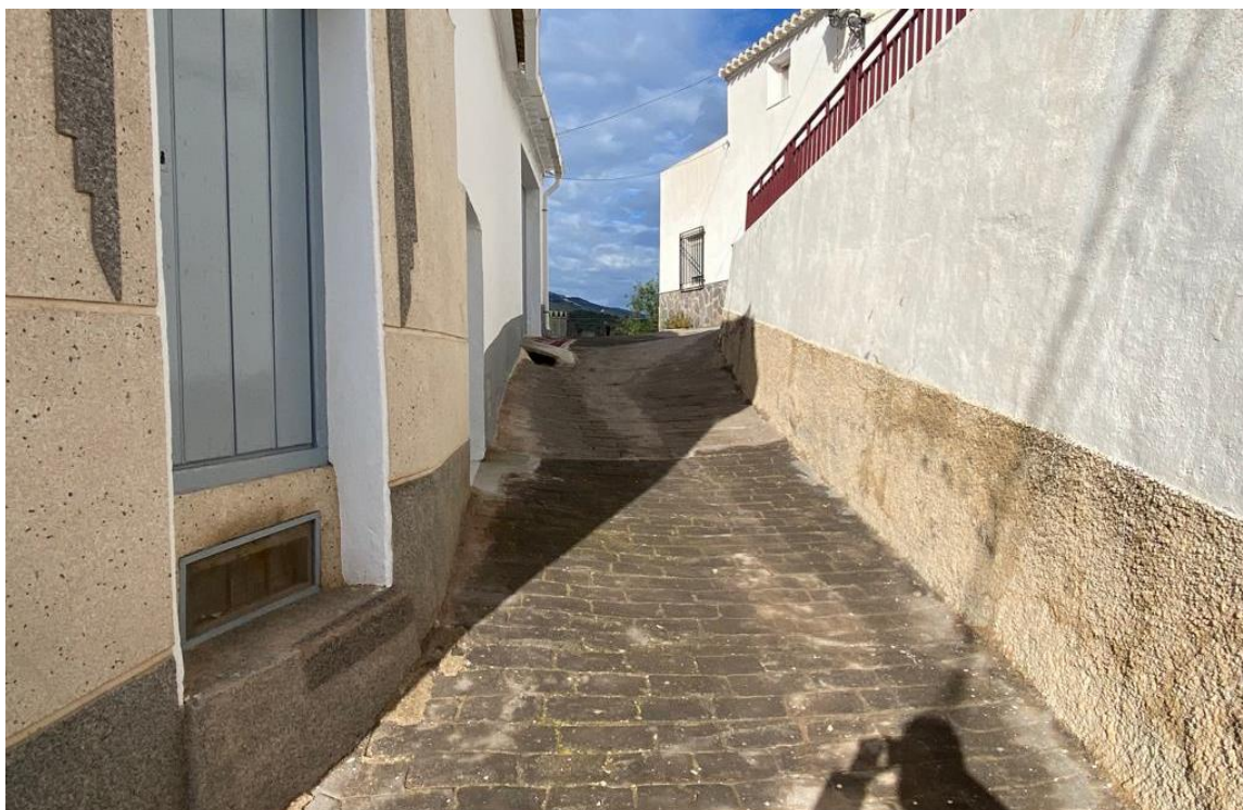
ACTUACIÓN 2. ACONDICIONAMIENTO DE LA CALLE CASTILLO.
