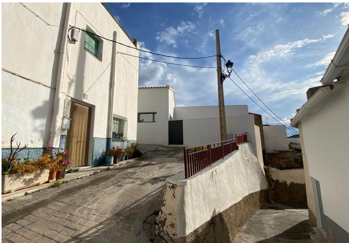
ACTUACIÓN 2. ACONDICIONAMIENTO DE LA CALLE CASTILLO.
