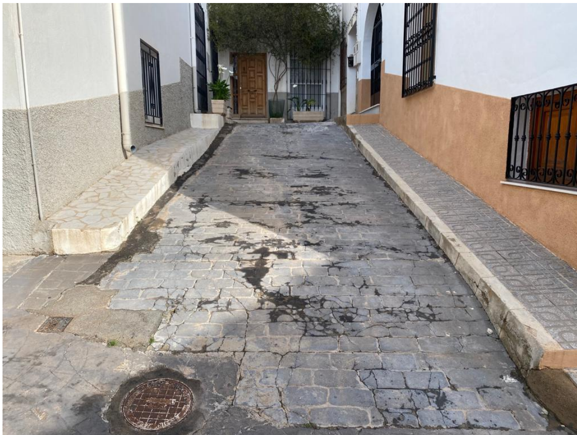
ACTUACIÓN 1. ACONDICIONAMIENTO DE CALLEJÓN EN LA CALLE ERAS.
